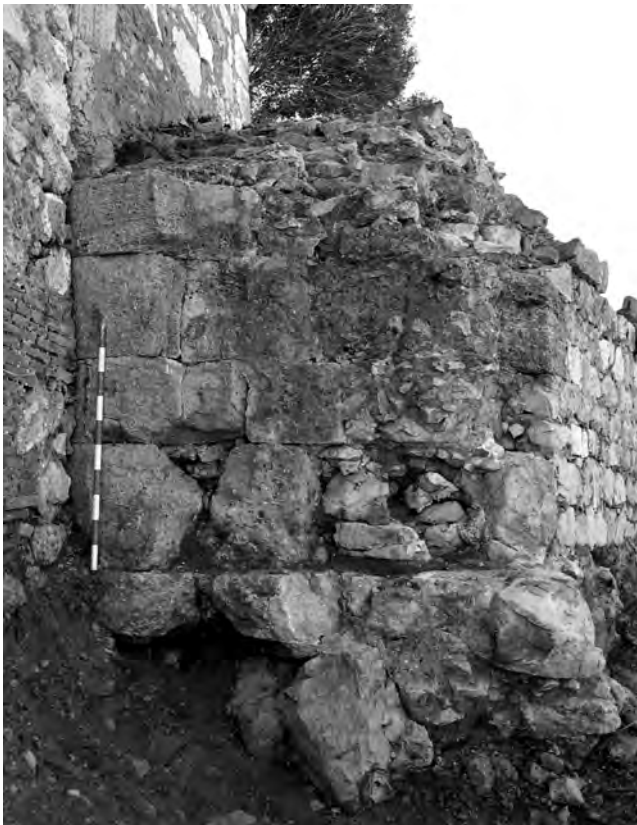
Figura 3. Jamba Este de la Puerta de Granada
